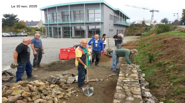
Construction de murets en granit
